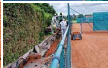
Vor kurzem musste ein Stromkabel neu verlegt werden
