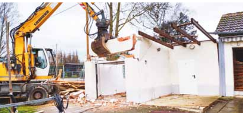
Abriss der alten Garage
